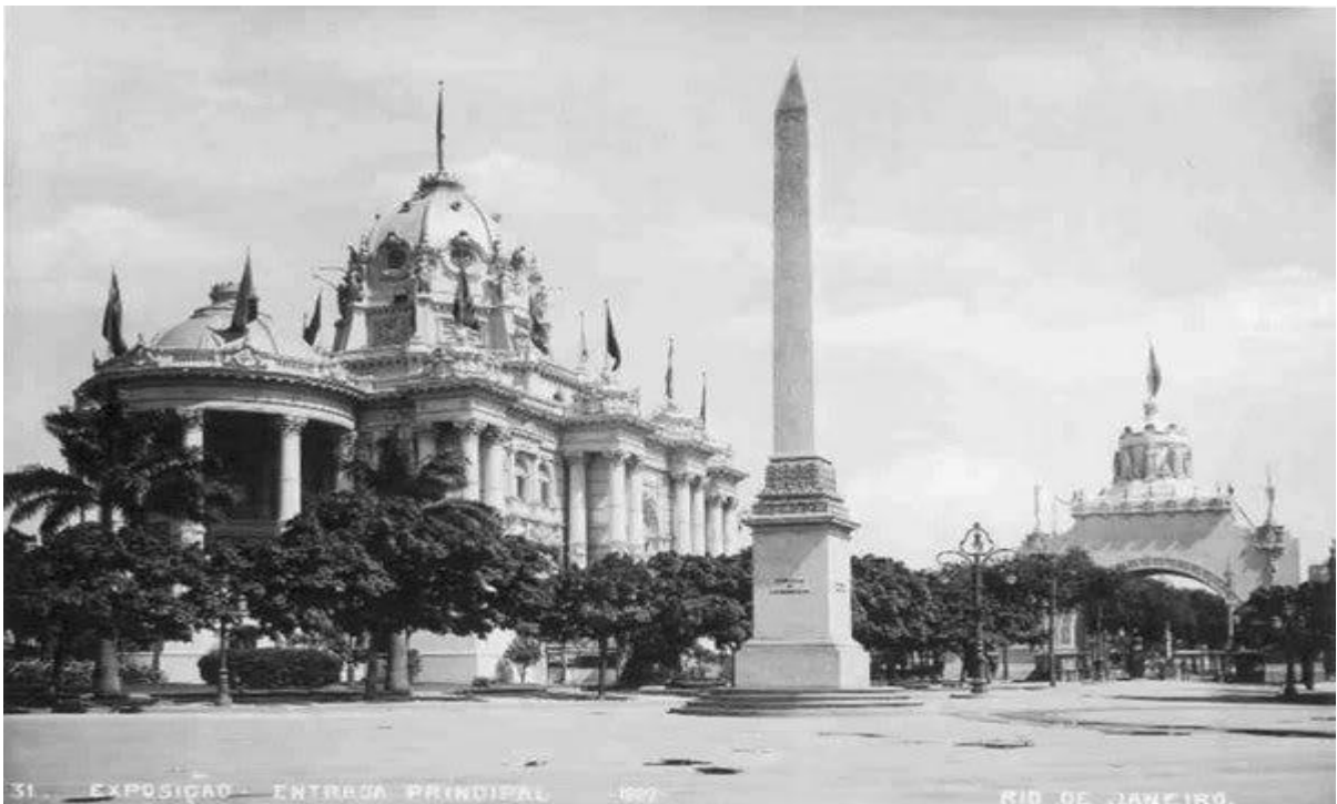
Foto 4 - Porta monumental da exposição, ao final da avenida Central. À esquerda, o Palácio Monroe. Desta fotografia o obelisco é a única construção que ainda existe.
