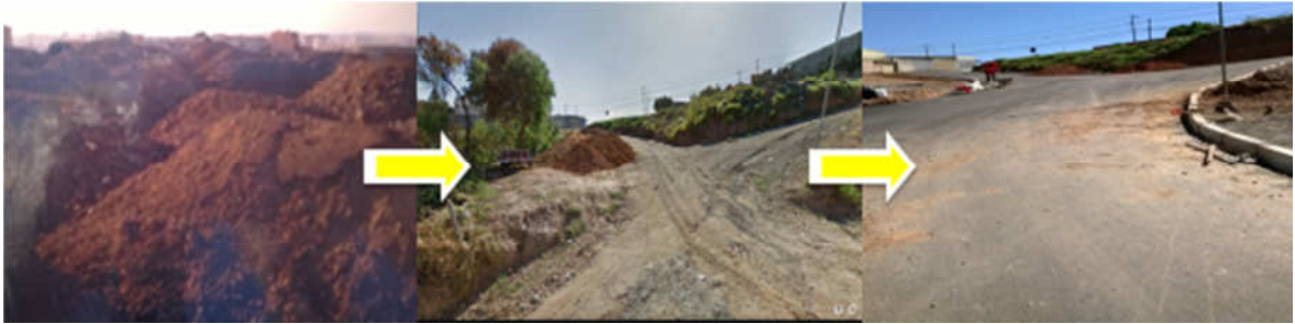
Figura 6 – Rua Glória nas Alturas em 1998, 2010 e 2014.
