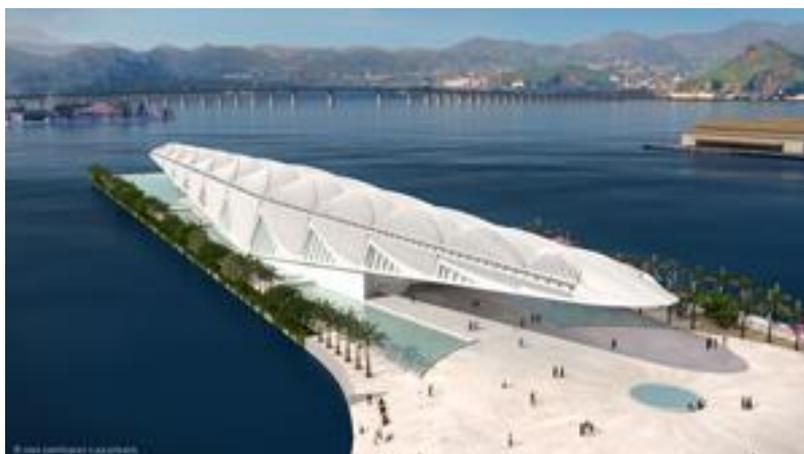
Museu do Amanhã: prédio terá grandes estruturas dinâmicas que se movimentam e servem não só para oferecer sombra, mas também formam bases para a instalação de placas fotovoltaicas para captação da energia solar que será convertida em elétrica
