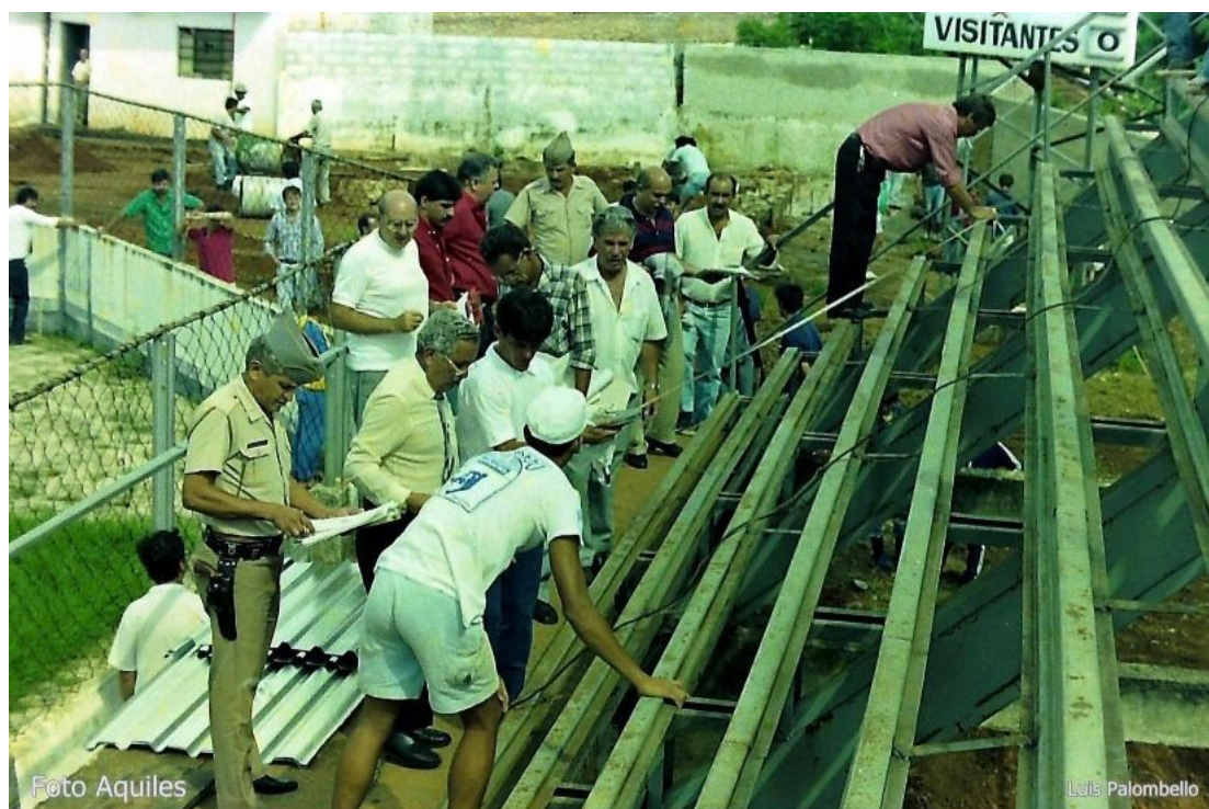
Figura 1 - Construção e Vistoria da Arquibancada.
